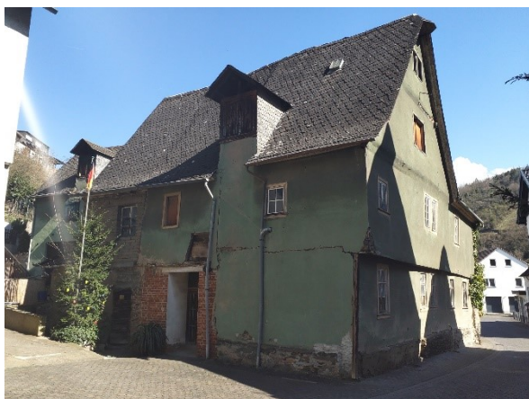
Abb. 17: West- und Süd- und Süd- und Süd- fassade Wohnhaus (Rheingoldstraße)
